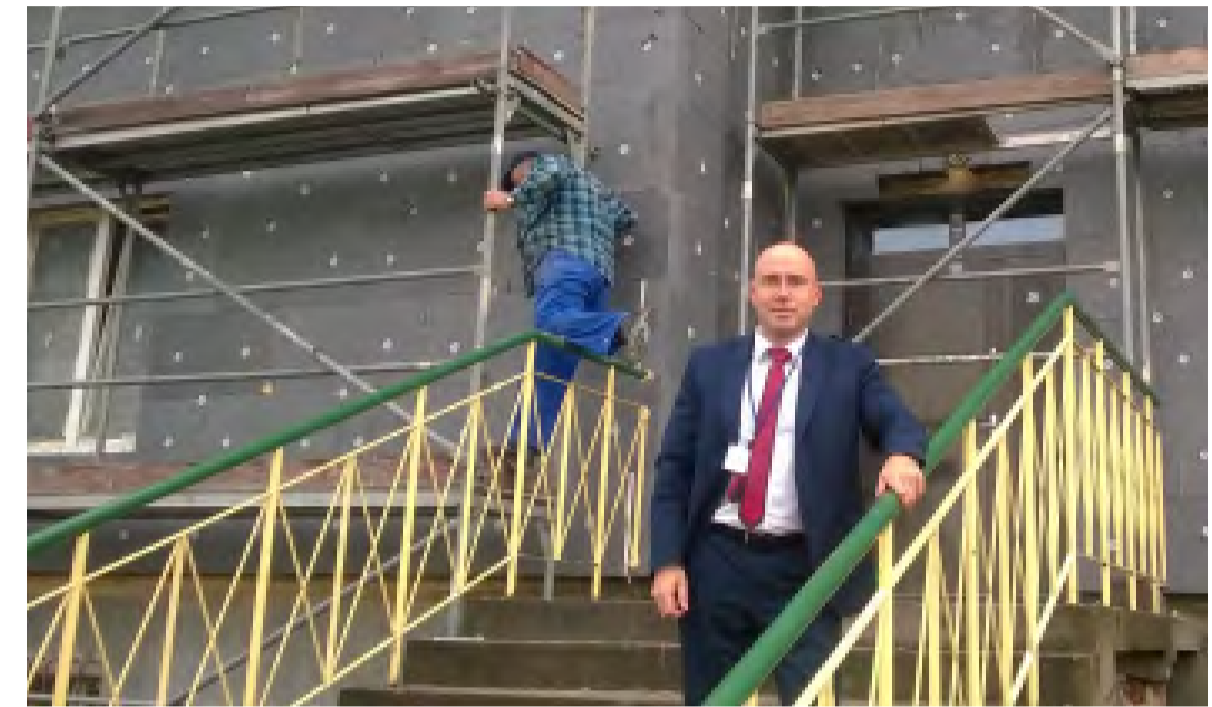
Dariusz Wójtowicz na tle remontowanej SP 15 w Wesołej.
